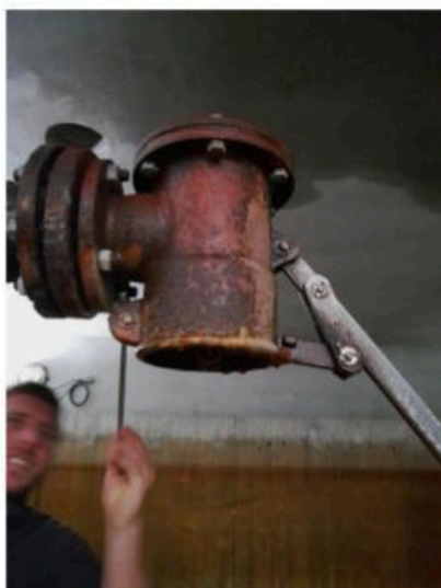
Photos Avant Travaux :
