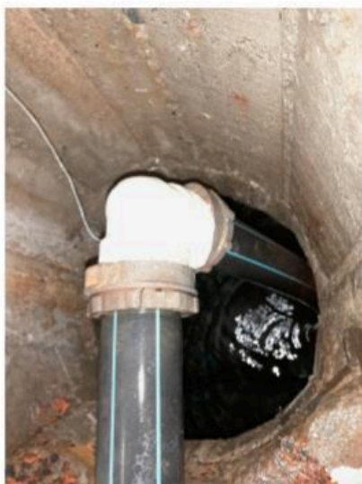
Photos Avant Travaux :
